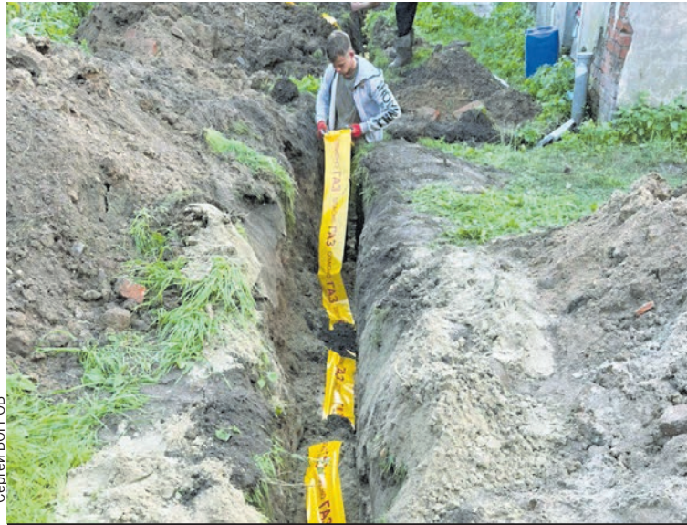
Уже завершены работы на участке на Русской набережной - проложен почти километр труб с вводами к двадцати домам.
