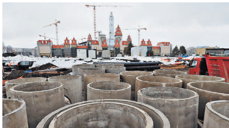
Вокруг крытой части «Острова Мечты» появится большой ландшафтный парк, а в 2020 году будут открыты новая набережная и детская яхтенная школа.
